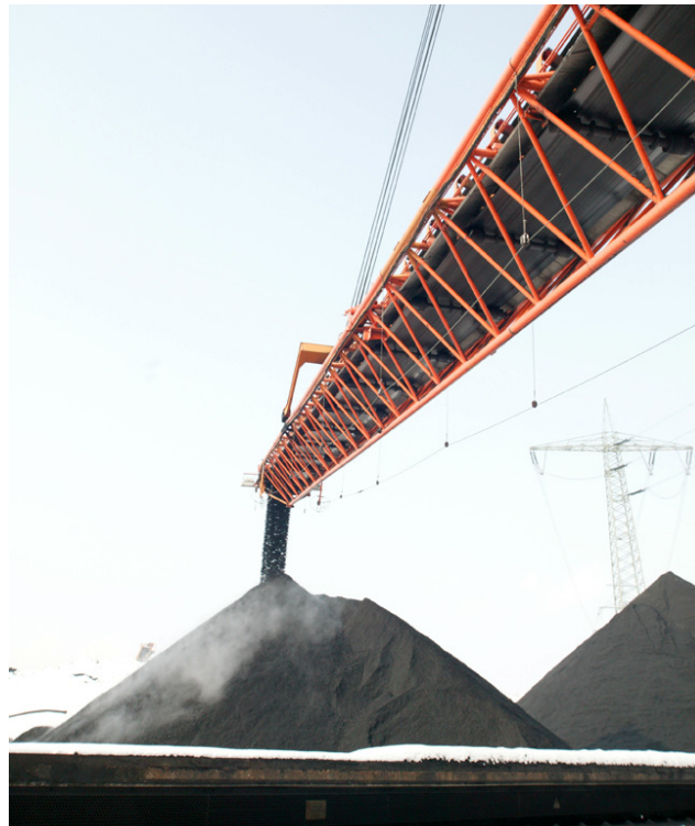
Kohlekraftwerk in Scholven
